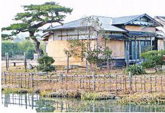
養生カバーが施された茶室
